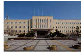
建設80周年となる和歌山県庁舎 ©長岡浩司
