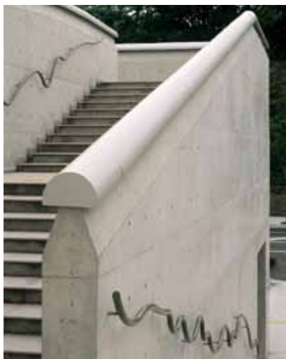
図 24 築地塀とフラクタルの手すり
