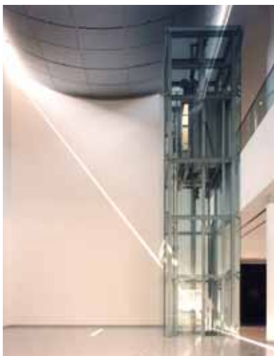
図 25 シースルーエレベーター
