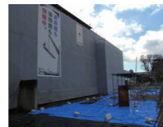
このなかに立派な足場があります。
