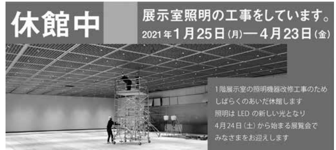
1階展示室照明設備取替工事中の看板
