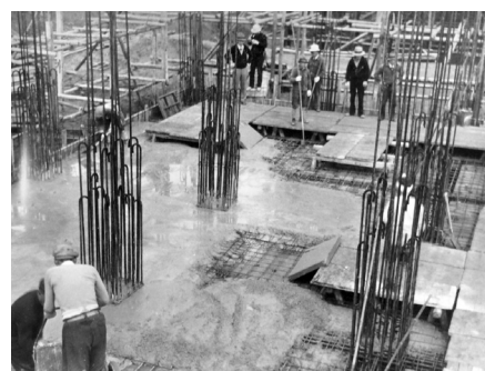
コンクリート打ち (和歌山県立文書館蔵)
