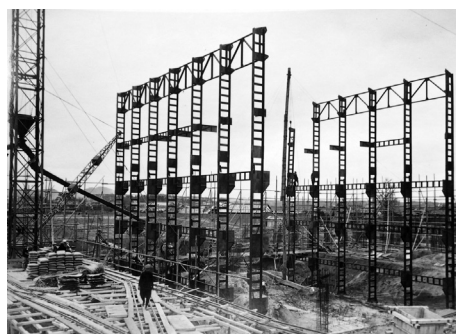
議場鉄骨建て方 (和歌山県立文書館蔵)
