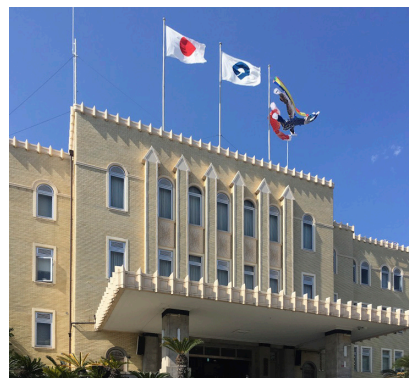
建設80周年を迎えた 和歌山県庁舎
