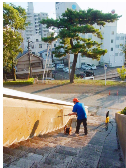
高圧洗浄機での洗浄作業
