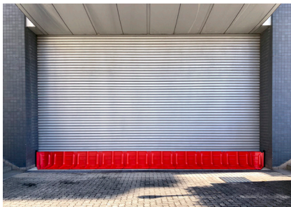
止水板を設置してみました
