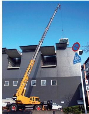
巨大なクレーンで新しい空調機を入れています
